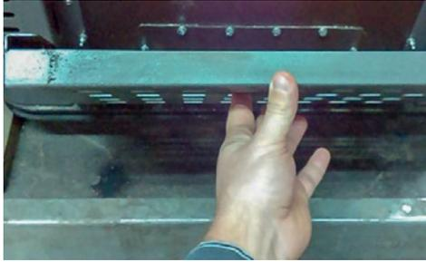
und darunter die **Serviceöffnung des zentralen Abgaskanals** unter einer fest verschraubten Abdeckung.
