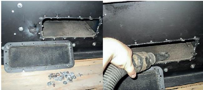
Im **Rhythmus von 1-2 Monaten** sollten die Muttern des Deckels entfernt und der darunter befindliche Raum zu gut wie möglich mit einem dafür geeigneten Sauger gereinigt werden.
