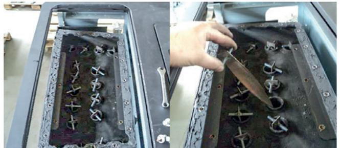
■ Sie finden darunter die Turbulatoren in den Rauchzügen des Wärmetauschers, ziehen sie sie **einzeln** heraus ...
