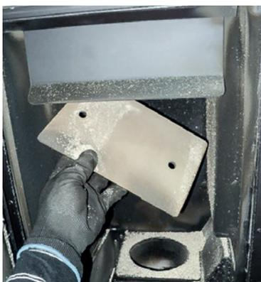
**Oberhalb des Brenners** befindet sich eine lose liegende Abdeckung, welche Rauchzüge und Turbulatoren vor starker Verunreinigung schützt. Entnehmen Sie dieses Blech **einmal die Woche** und säubern Sie das Blech und die dann freiliegenden Öffnungen des Wärmetau-
