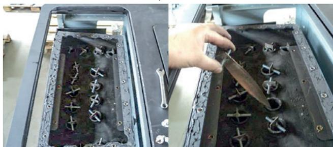
■ Sie finden darunter die Turbulatoren in den Rauchzügen des Wärmetauschers, ziehen sie sie **einzel**n heraus ...
