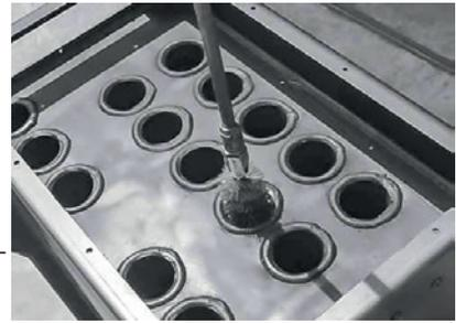
■ In umgekehrter Reihenfolge erfolgt der Zusammenbau. Achten Sie auf den dichten Sitz der Wärmetauscherabdeckung und den Zustand der ihrer Keramikdichtung. Es muss ausgeschlossen sein, dass hier Rauch austreten kann.
