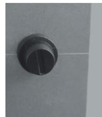
■ **„Alar Sic Fail“:** In seltenen Fällen könnte im Pelletvorratsbehälter eine zu hohe Temperatur gemessen werden, das Gerät löst aus Sicherheitsgründen die Thermo-sicherung aus, die bei einigen Modellen wie im Bild doppelt ausgeführt ist: Oben -> Wasser, unten -> Pellets.
