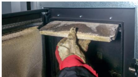
nehmen Sie oben vorsichtig die Flamm-Schutzplatte die den Röhrenwärmetauscher vom Brennraum abschließt. Gehen Sie dabei vorsichtig vor – es handelt sich um ein wärme-festes und brüchiges Material! Saugen Sie die Plattenoberseite und -unterseite, sowie den Auflagebereich der Platte und die Unterseite des Wärmetauschers sorgfältig ab und installieren Sie die die Platte wieder an Ihren ursprünglichen Platz.
